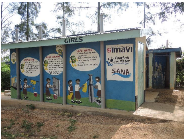
Getrennte Toiletten für Jungen und Mädchen können dazu beitragen, dass vor allem mehr pubertierende Mädchen zur Schule gehen. So fühlen sie sich beim Gang zur Toilette sicherer, insbesondere an den Tagen, an denen sie das Bedürfnis nach spezieller Hygiene haben und die Toiletten entsprechend eingerichtet sind. Foto/Marc Tornow
